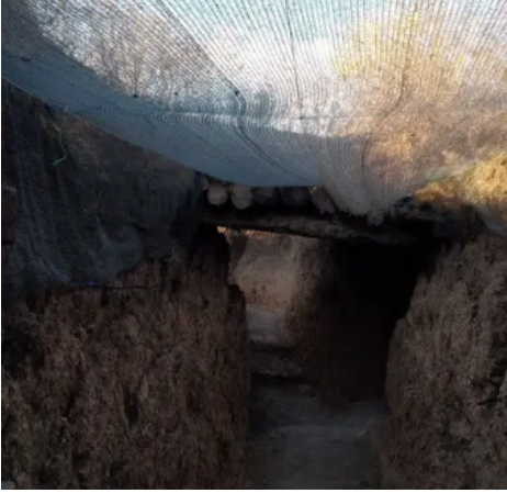
Рисунок 5.9 – Окопна система, накрита флізеліною тканиною «Спанбонд»
