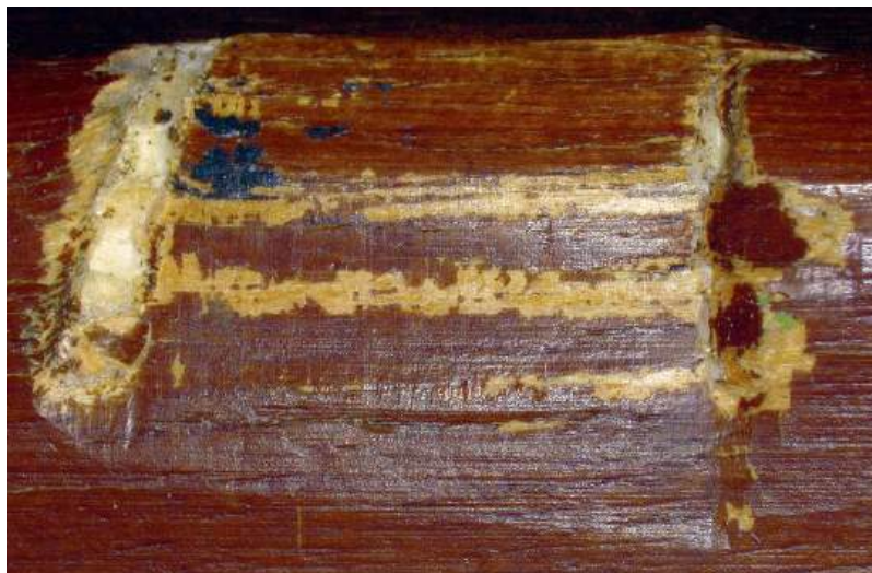
Сліди віджиму на коробі дверей.
