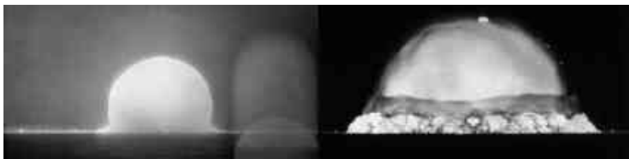
Рисунок 1.4 – Архівні фото випробування «Триніті»: ліве зображення зроблено через 0,006 с після детонації, праве – через 0,034 с
