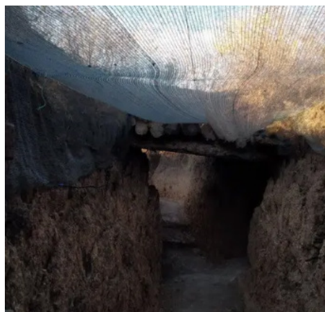
Рисунок 5.9 – Окопна система, накрита флізеліною тканиною «Спанбонд»
