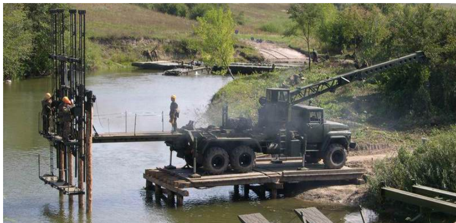
Рис. 7.13 Загальний вигляд УСМ-2
